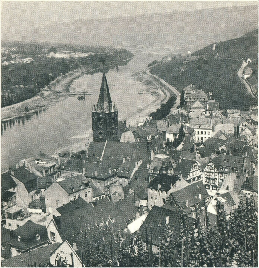
Ausbau der Mosel
